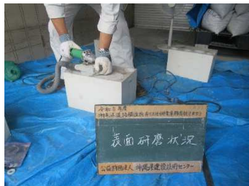
写真-12 コンクリートの表面研磨状況
