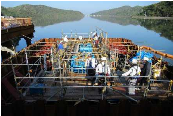
写真-13 生コン打設立会い状況
