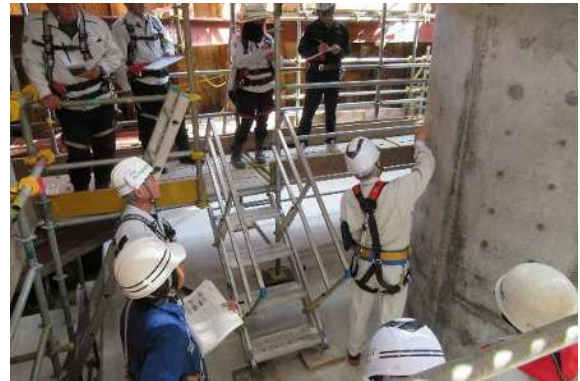
写真-14 コンクリートの表層品質確認状況
