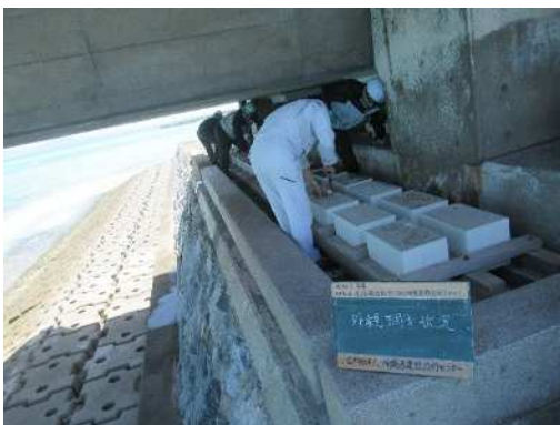
写真-11 外観調査状況
